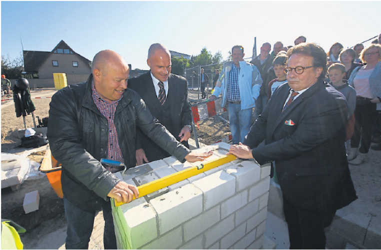
Letzter Feinschliff bei der Grundsteinlegung: Aufsichtsratsvorsitzender Peter Bölting (li.), der zukünftige Bürgermeister Jürgen Bernsmann und Stadtwerkechef Dr. Ronald Heinze haben gerade eine Zeitkapsel eingemauert und ruckeln mit der Wasserwaage die Steine gerade. Foto: Sven Betz
